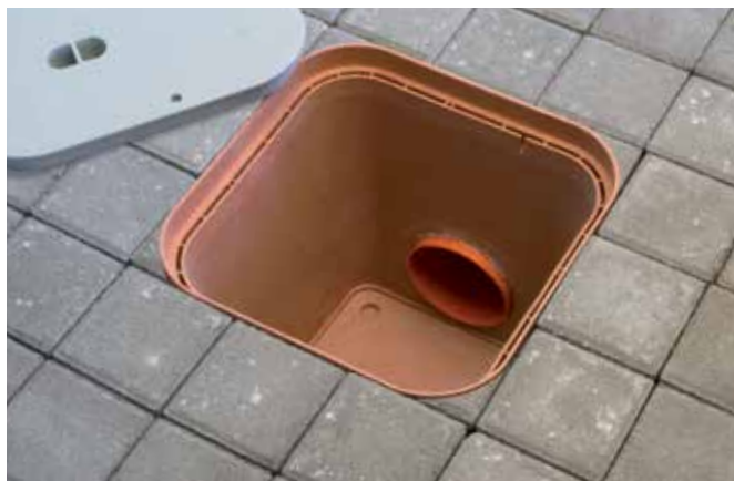
Instalación de un tubo de agua Water pipe installation
