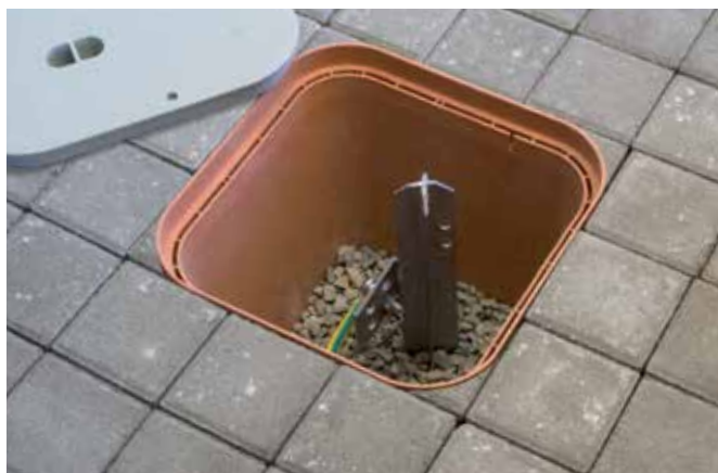
Instalación de un dispersor de tierra Heathring rod installation
