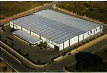
Protubsa Almacén Tarragona
