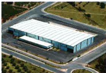
Protubsa Almacén Tarragona
